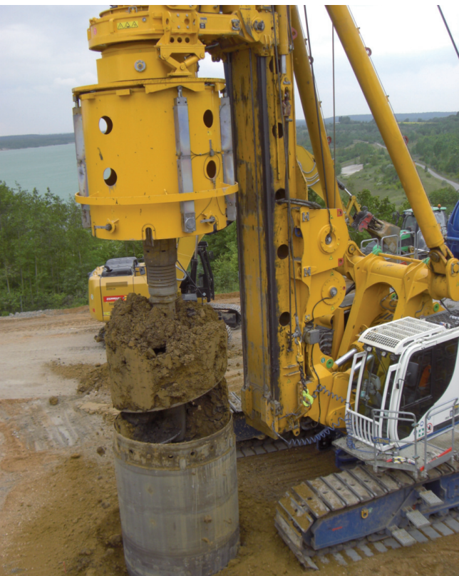
Austauschbohrungen zur Hangstabilisierung an der A 72, Höhe Hainer See
